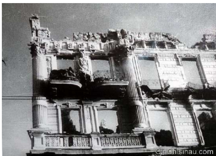
Imaginea 122 - Un fragment din clădirea distrusă din centrul Chișinăului (Oldchisinau.com.)
