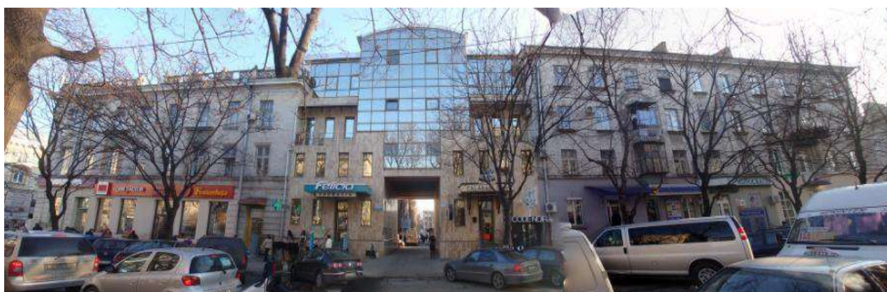
Imaginea 129 - Schimbarea clădirilor detașate și transformarea lor într-o structură liniară perimetrală str. Armenească (arhitect Lupașcu V.)
