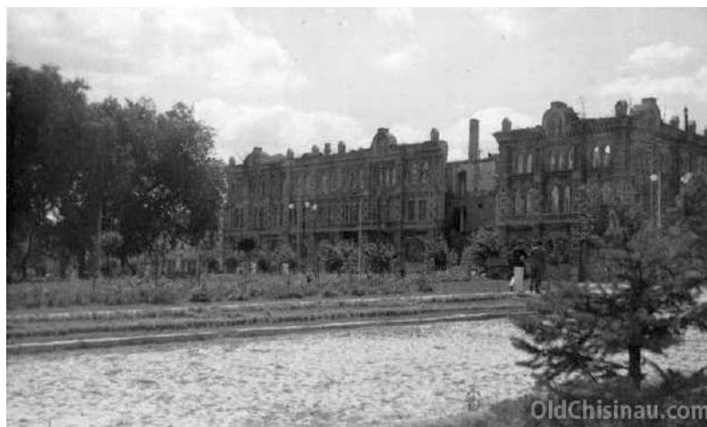
Imaginea 123 - Clădirea stricată a Casei Eparhiale
